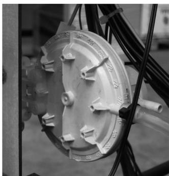
**Pressostato fumi:** controlla la pressione nel condotto fumario. Esso provvede a bloccare la coclea di caricamento pellet nel caso lo scarico sia ostruito o ci siano contropressioni significative ad esempio in presenza di vento. Nel momento di intervento del pressostato apparirà la scritta **"ALAR-DEP-FAIL"**.
